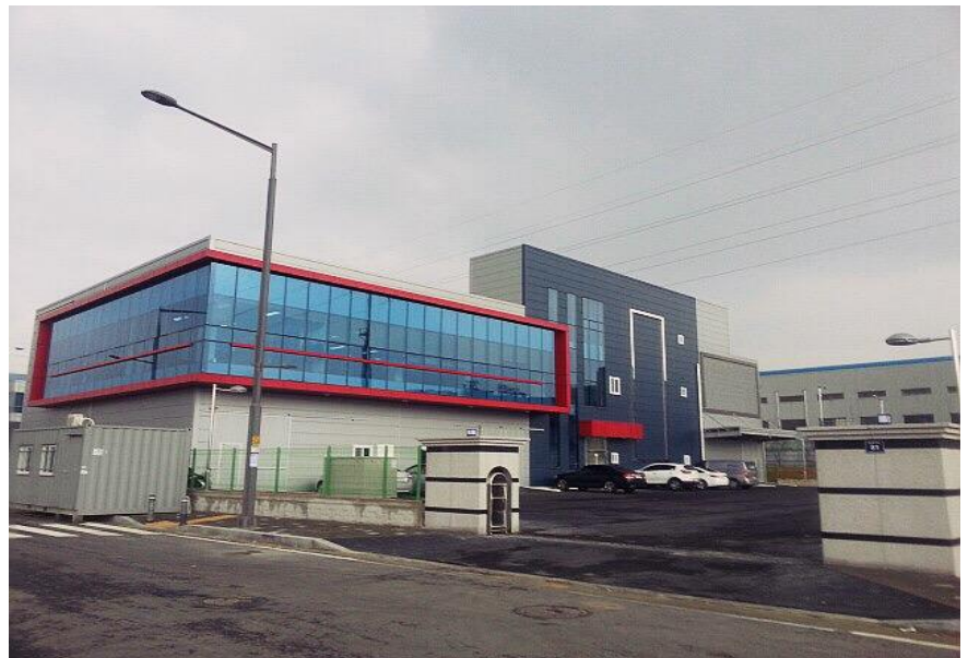
(주)파트너 김포골드밸리 공장 신축공사
