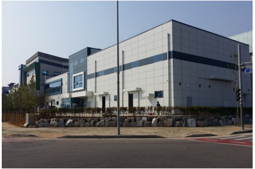
인천광역시 서구 오류동 1548-7번지 유창성업(주) 공장 신축공사
