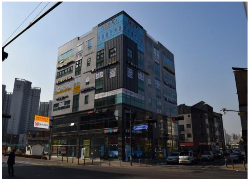
장기동 2039-1 근린생활 신축공사(두현프라자)
